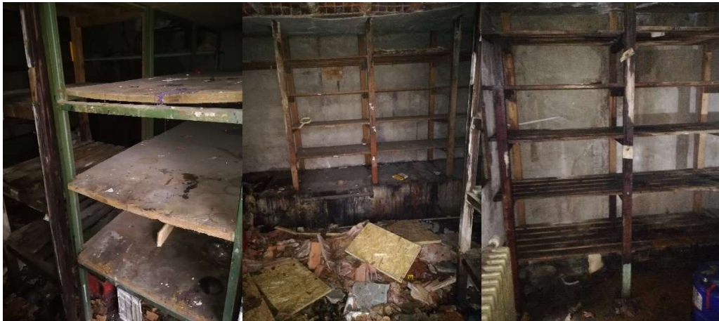
Figure 5 : Intérieur des locaux après évacuation des déchets
